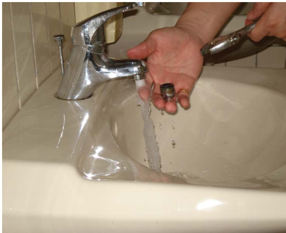
水龍頭節水閥更換實況-2
