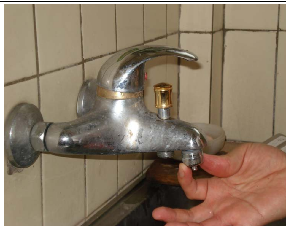
水龍頭節 水閥更換 實況-3
