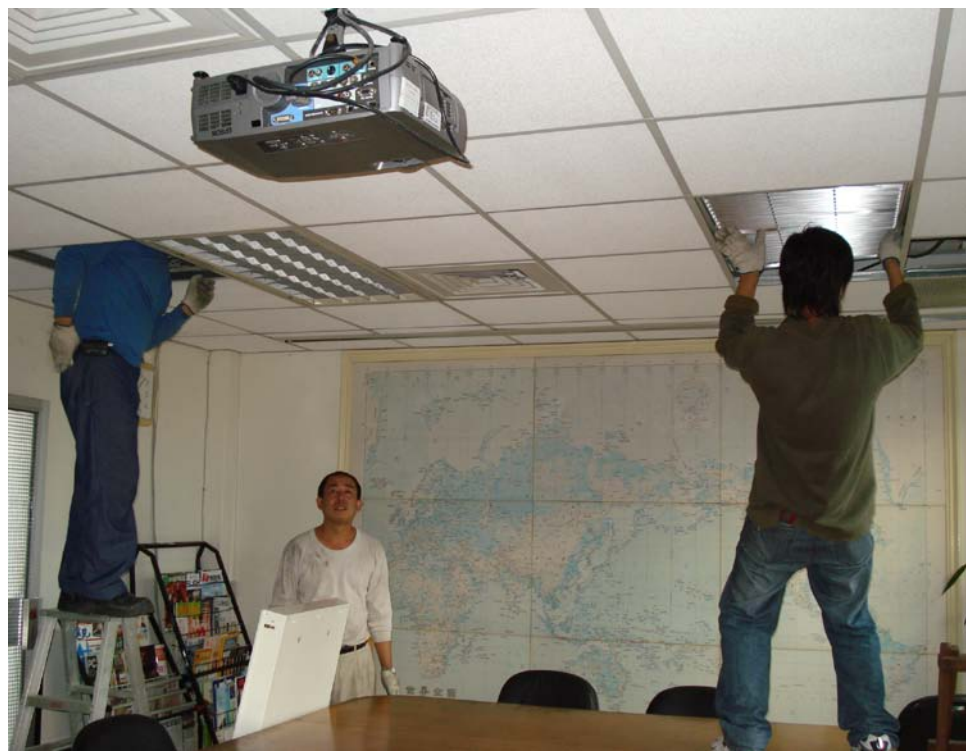
照明燈具 更換施工 情形
