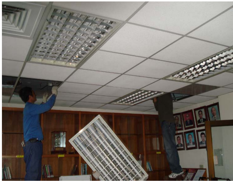
照明燈具 更換施工 情形
