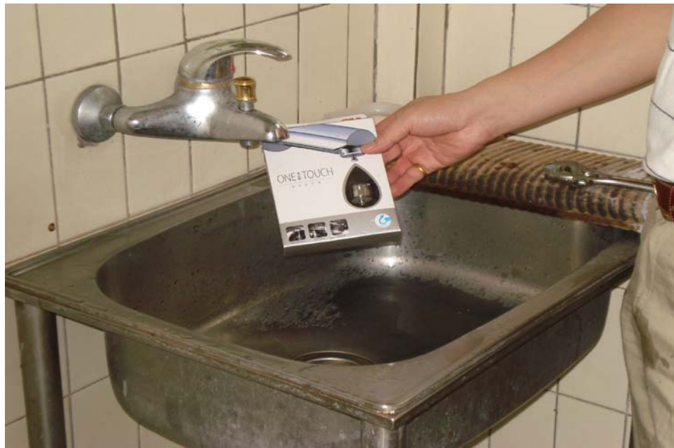
水龍頭節水閥更換實況-1
