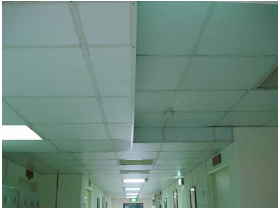
天花板更換後，整齊、光亮。乳白色系列，增加光線反射及漫射效果
