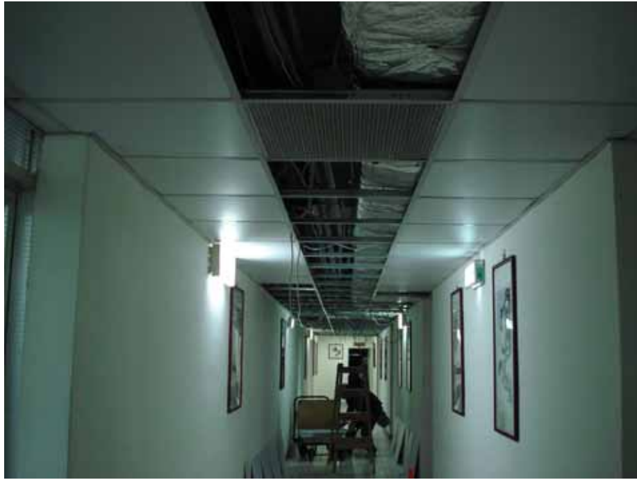
更換燈具 施工情形
